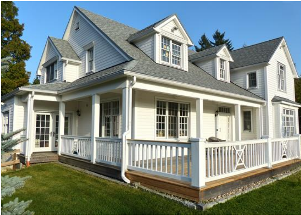
SERIES-300-STANDARD OPEN HOUSE; erbaut von TWH im Großraum Düsseldorf
